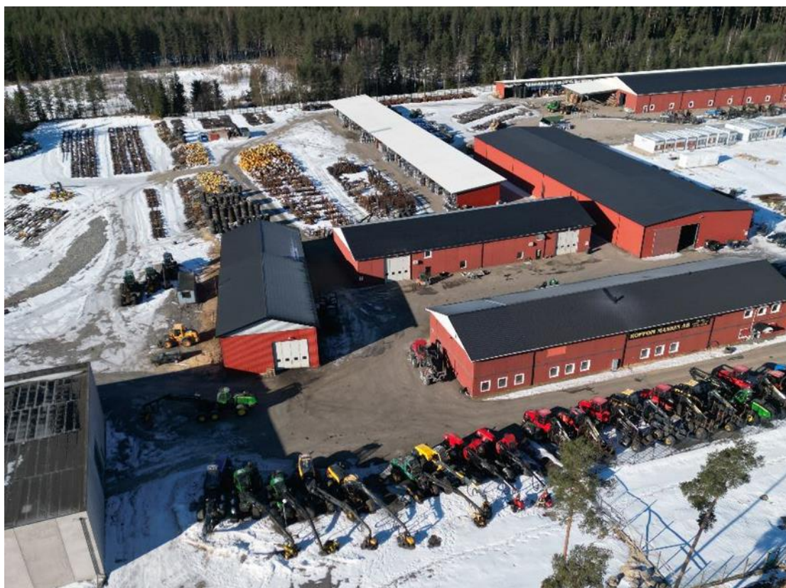
Koppom maskin sett från riksväg 61, all verksamhet sker på baksidan av befintlig huskropp, bort från vägen.
