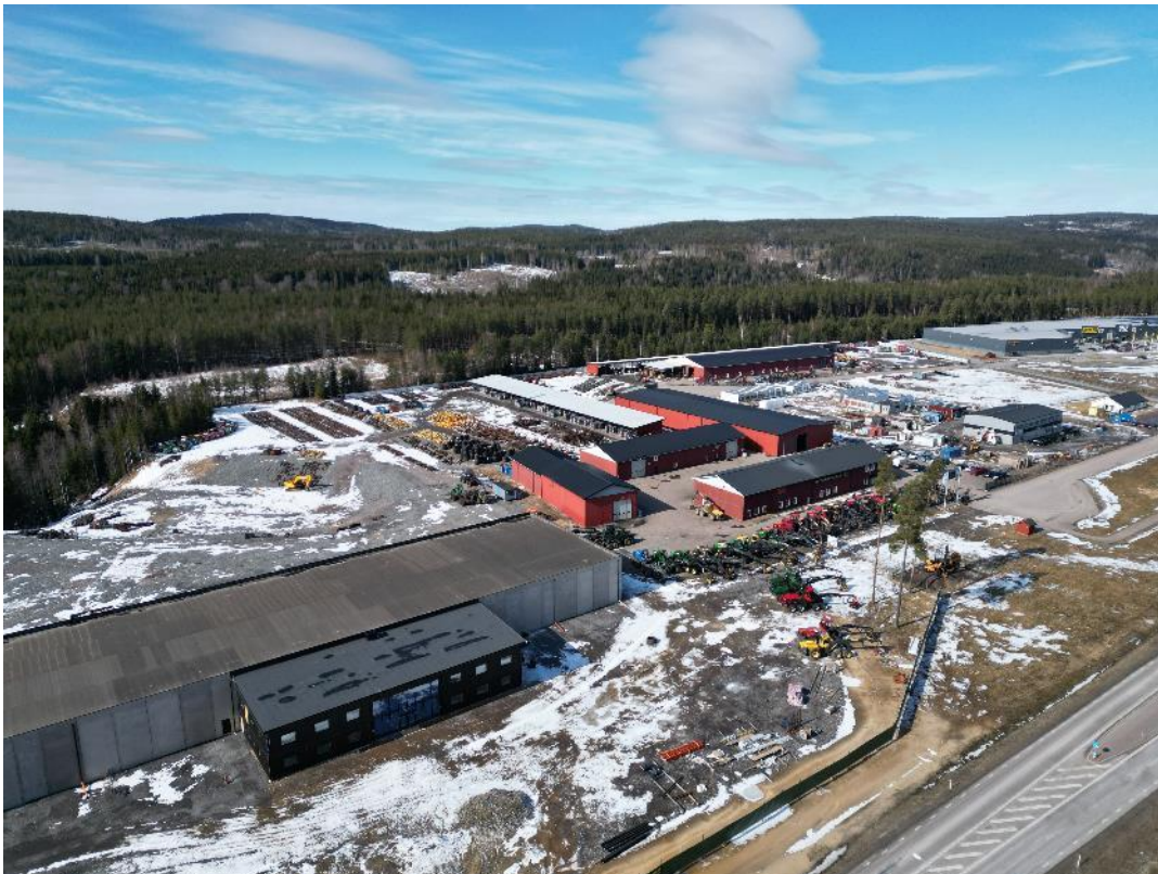
Koppom maskin sett från riksväg 61, all verksamhet sker på baksidan av huskroppen, bort från vägen. Byggnad till vänster i bild är under uppförande och ny placering av demonteringslokal planeras bakom den.
